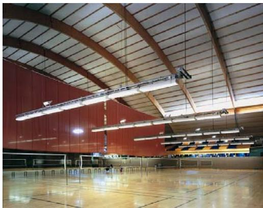
Система LightLift в рабочем положении
